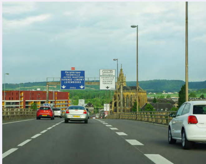
Figure 12. L'A31 dans sa traversée de Thionville
