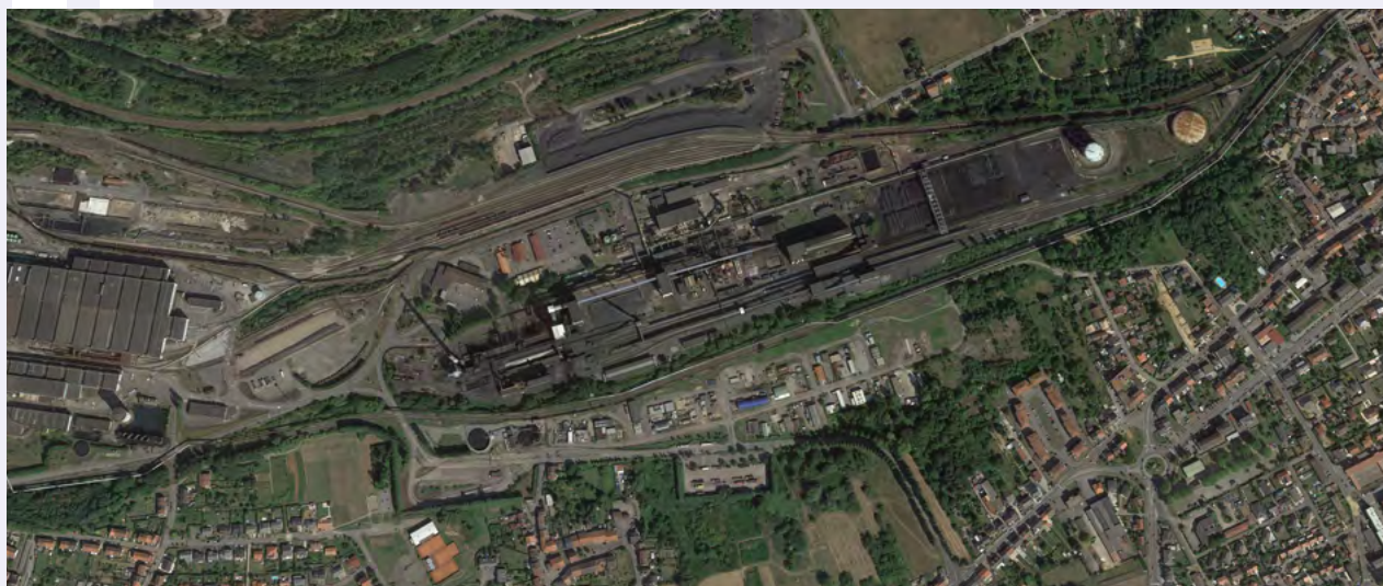
Figure 5. Cokerie de Seremange-Erzange
