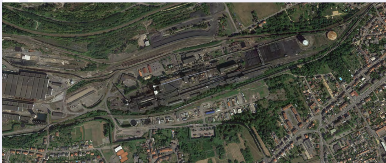
Figure 5. Cokerie de Seremange-Erzange
