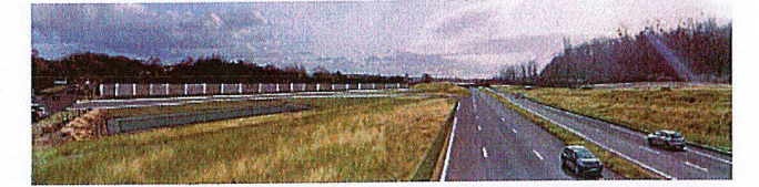
Figure 26 - Vue entrée section souterraine - Tête nord depuis Luxembourg
