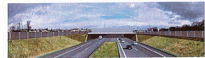
Figure 24 - Vue entrée section souterraine - Tête sud depuis Fameck
