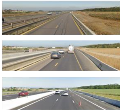
Des coupures ponctuelles et de nuit seront sans doute nécessaires pour certains travaux sur les ouvrages d'art, notamment pour leur démolition quand celle-ci est prévue. Ensuite, les nouveaux ouvrages seront conçus de manière à gêner le moins possible la circulation avec des travaux de nuit sous coupures pour la pose des structures principales et de jour sous circulation pour les travaux d'achèvement. En cas de coupures, des itinéraires de déviation seront mis en place.
